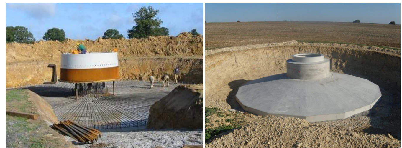
Photo 2 : Le ferrailage et le coulage d'une fondation d'éolienne
