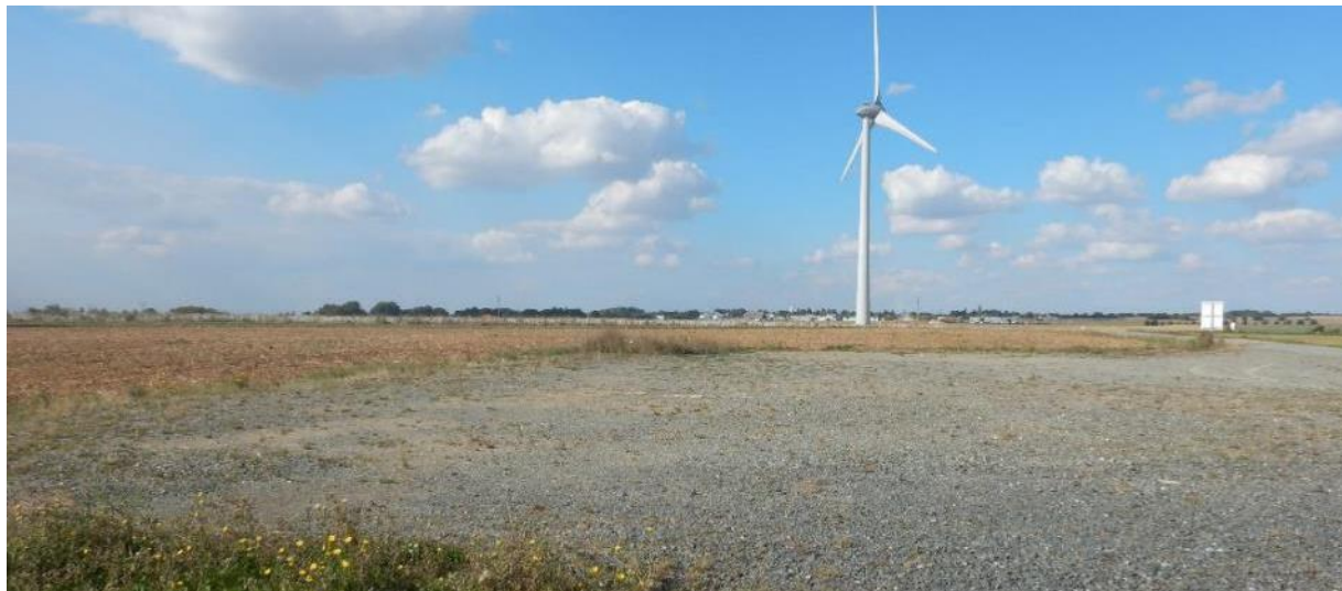
Photo 3 : Un exemple d'aire de grutage depuis le pied d'une éolienne
